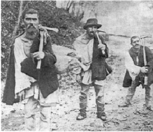
Rudari din Valea Marisărilor-Muşcel, aducând material lemnos din pădure, pe jumătate cioplit.
