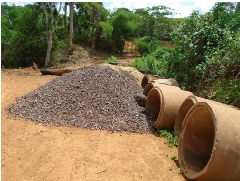
Photo 5 : travaux de construction du pont entre Koufouho et Sapia (Photo Adou, mai 2017)
